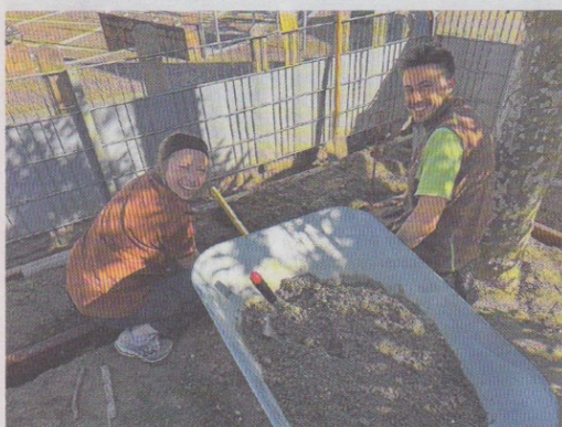
Bei der Bodenvorbereitung
